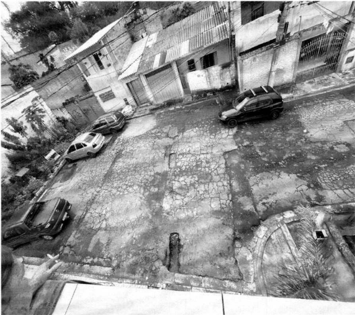
PAVIMENTAÇÃO ASFÁLTICA NO FINAL DA RUA OIAOQUE, VILA PAULISTA- MOGI DAS CRUZES.
